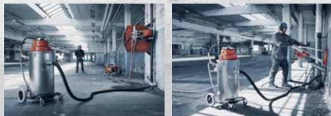
Bei nassen Trenn-/Bohrverfahren wird der Staub direkt am Entstehungsort mit Wasser gebunden. Die Vorrichtung zum Aufsammeln des Schlammes kann an einen Schlammsauger angeschlossen werden, um den Arbeitsplatz sauber zu halten.
