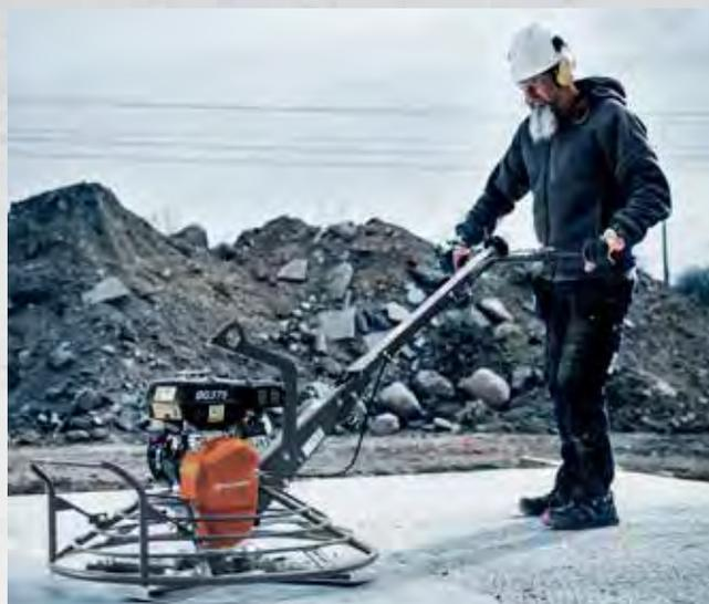
**STAHLABZIEHFLÜGEL.** Abziehflügel werden zum Abziehen der Betonoberfläche in der Anfangsphase des Betonendbearbeitungsprozesses verwendet. Husqvarna Abziehflügel haben eine nahezu flache Oberfläche, wodurch der Sog zwischen Flügel und Oberfläche entsteht. Dadurch wird der Beton von einer höheren zu einer niedrigeren Position auf der Platte bewegt.
